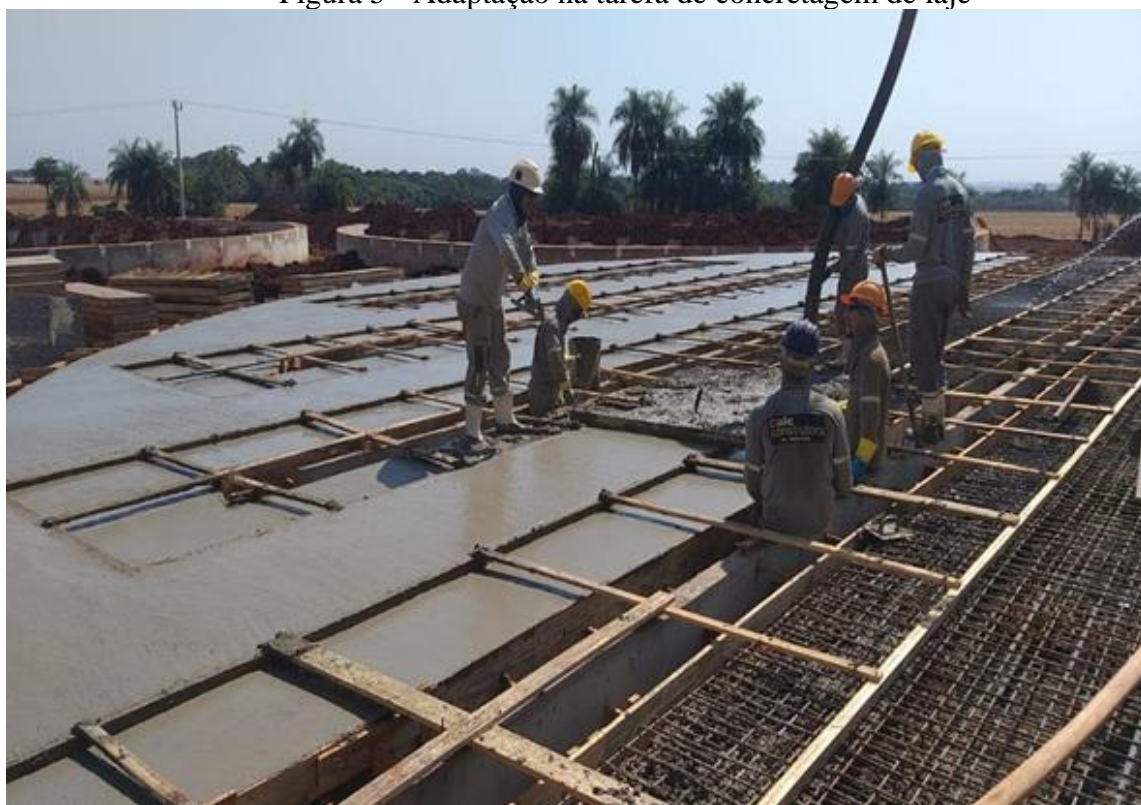
Figura 5 - Adaptação na tarefa de concretagem de laje
