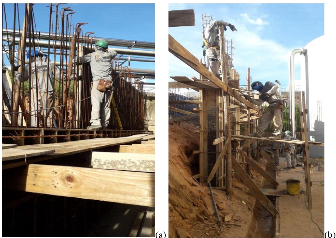
Figura 6 - Adaptação e variabilidade na tarefa de montagem de formas
